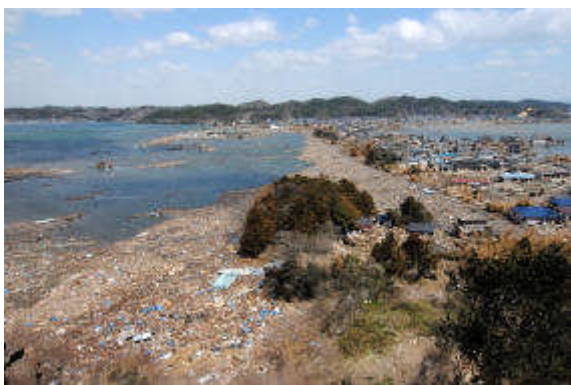
防潮堤(破線部分)が内側から破壊され、海水に漬かったままの東名地区。左奥が松島湾。中央の茶色い部分はがれき＝12日、東松島市
